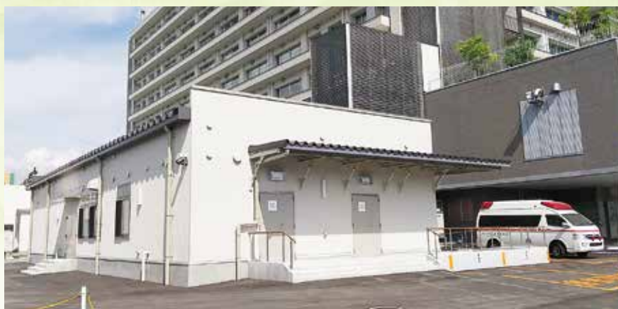
トリアージセンター 建物外観
